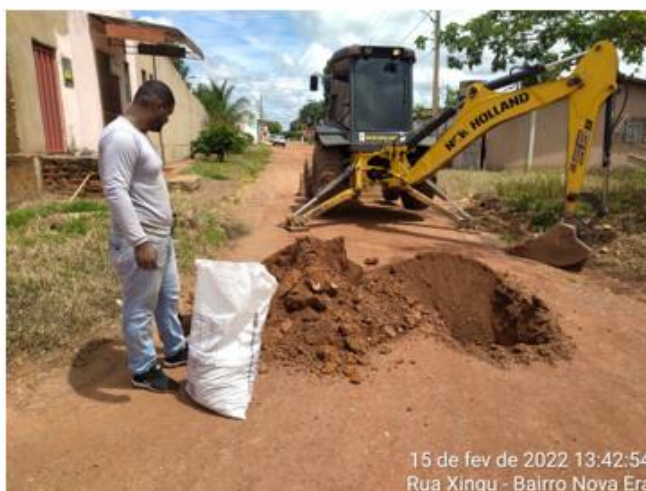
Coleta dos furos de sondagem
